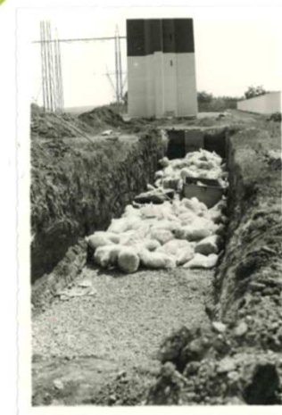
Fase di riempimento Trincea 1
